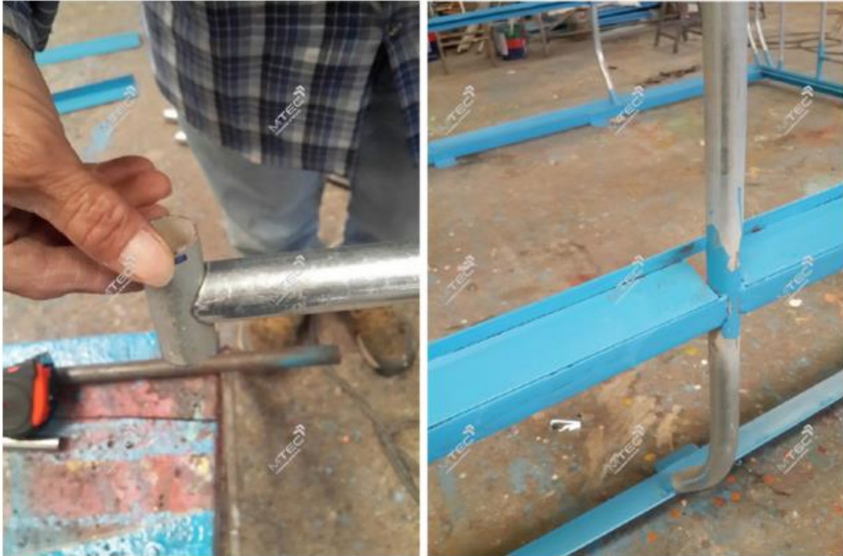
รูปที่ 8 การบากท่อเหล็กเพื่อเชื่อมต่อชนทำโครงหลังคา
