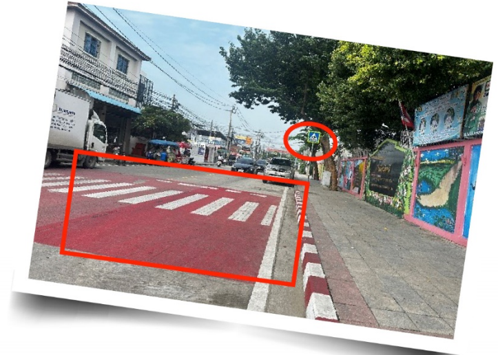
ปรับปรุงทางม้าลาย และติดตั้งป้ายพื้นที่หน้าโรงเรียน
