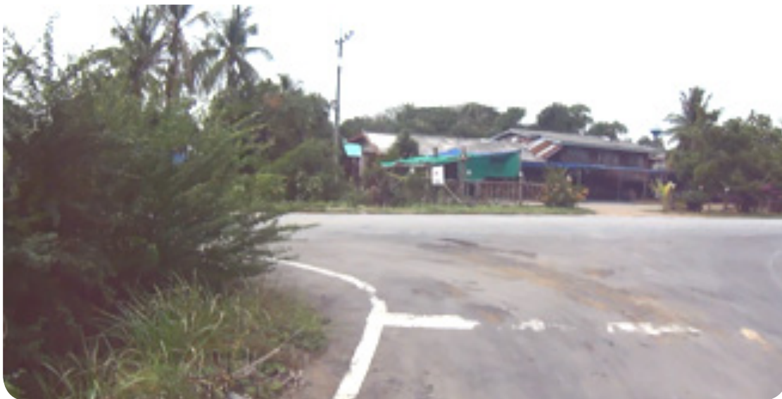
พุ่มไม้ทางซ้ายทาง บดบังทัศนวิสัยของรถจากทางโท ที่มาจอดรอเลี้ยวเข้าทางหลัก (ภาพจาก อนต.ท่านนาว จ.ลพบุรี)
